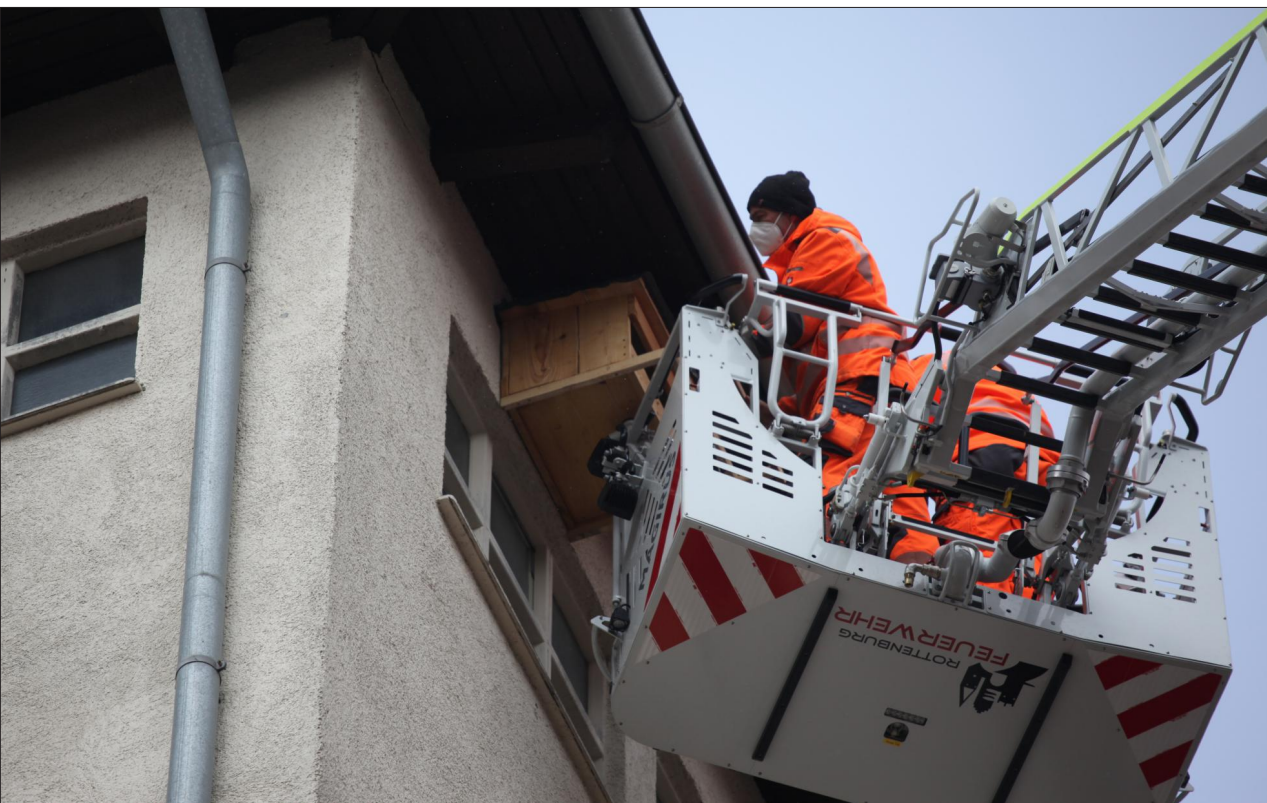
Von der Drehleiter aus wurde der Falkenkasten unter dem Dach montiert.
